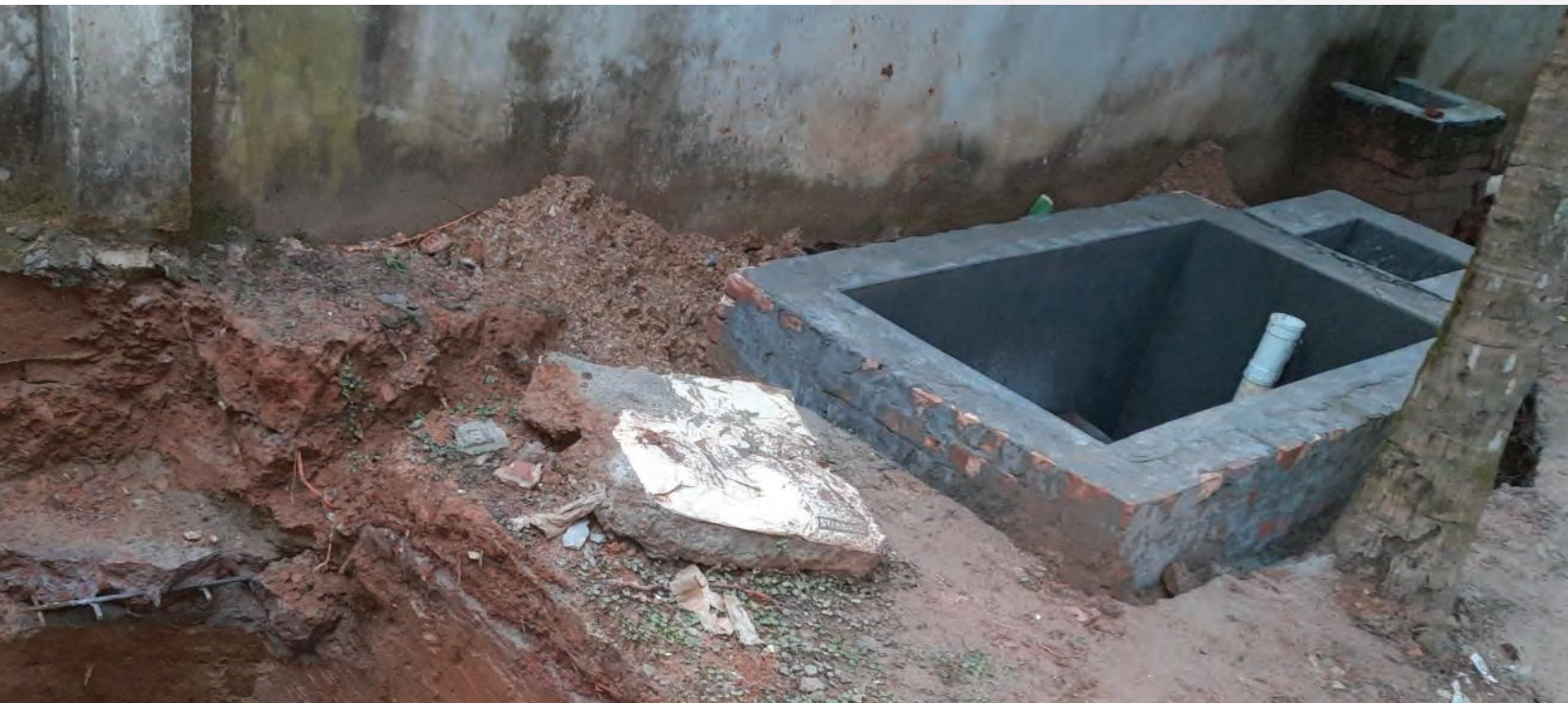
চিত্র ৩ঃ ইটের গাঁথুনি দ্বারা নির্মাণাধীন এক কক্ষবিশিষ্ট সেপটিক ট্যাংক Fig. 3: Single chamber septic tank by brick masonry is under construction
