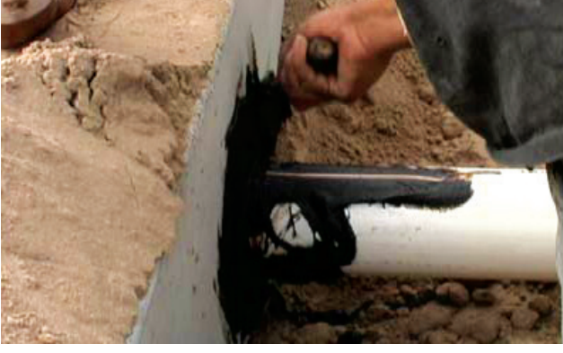
চিত্র ২০ঃ সেপটিক ট্যাংকের ইনলেট/আউটলেট গর্তগুলি গ্রাউট বা মর্টার ব্যবহার করে সিল করা
