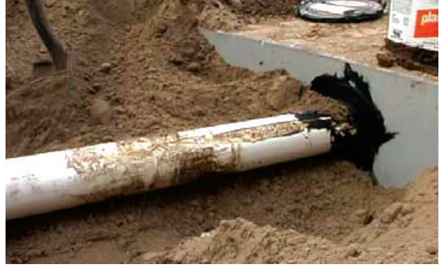
চিত্র ২০ঃ সেপটিক ট্যাংকের ইনলেট/আউটলেট গর্তগুলি গ্রাউট বা মর্টার ব্যবহার করে সিল করা
